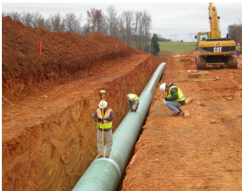
3 Сурет – Жерасты коммуникацияларын ашық тәсілмен төсеу
